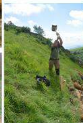
Mise en place des boudins en fibre de coco pour tenir les talus (équipe Parc, aide ponctuelle Lycée Agricole -chantier école)
