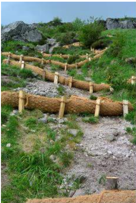
Toilage en bionatte de fibre de coco et boudins en fibre de coco pour lutter contre l'érosion (fermeture des ravines)
