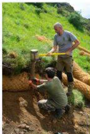
Mise en place des boudins en fibre de coco pour tenir les talus (équipe Parc, aide ponctuelle Lycée Agricole -chantier école)
