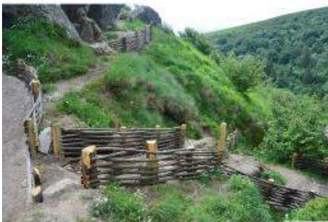
Réalisation d'embranchements (dont caissonnage) et tressages en perches de châtaigner - Equipes Parc
