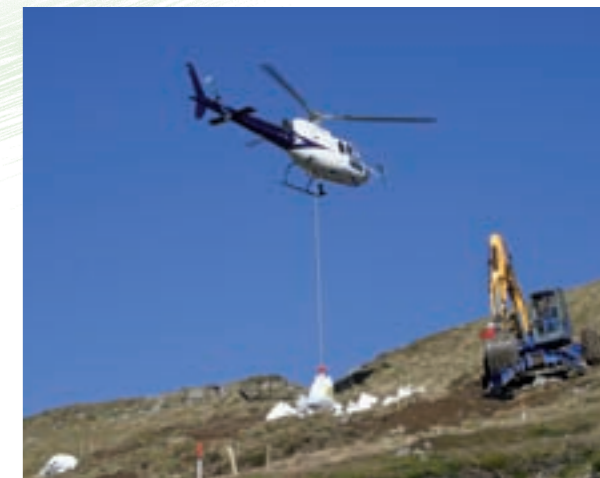
Travaux de réhabilitation des sentiers du puy Ferrand.
