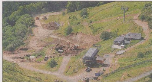
FONCTIONNEL. En cours de terrassement, le site de la future gare de départ du télésiège de La Combe a été déplacé de quelques mètres. De même que la piste d'entrée sur la familiale va être élargie pour atteindre une soixantaine de mètres.
