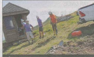
SPECIALISTES. Les équipes du chantier sont issues d'une entreprise spécialisée basée à Pontamfrey, qui travaille avec le constructeur de remontées mécaniques Gimar Montaz Mautino.
