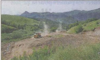
CALENDRIER Le chantier du télésiège de La Combe a débuté mi-juin. La livraison est prévue pour début décembre.
