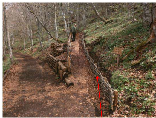
Tressages pour canaliser la fréquentation sur le nouveau chemin
