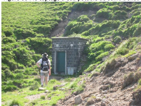
Figure 60 : le captage d'eau potable de Saint-Donat
