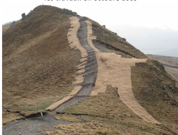
Figure 75 : le sentier du puy de la Perdrix juste après les travaux en octobre 2009
