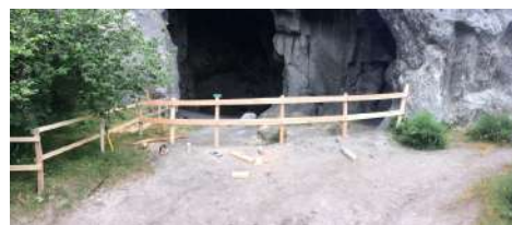
Mise en défens de la Grotte du Sarcoui © SMPNRVA
