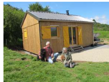
Appui à l'aménagement d'une cabane de berger sur l'estive d'Orcines © SMPNRVA
