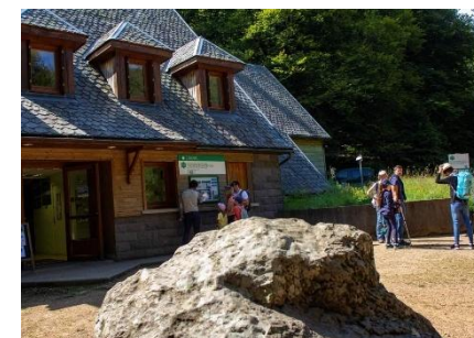
Maison d'accueil de la Réserve naturelle de la Vallée de Chaudesfour © SMPNRVA
