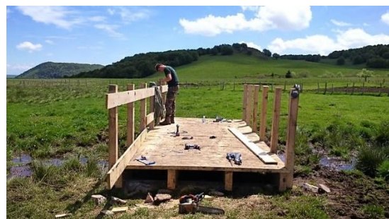
Aménagement d'une passerelle sur l'estive des Listes © E-Mardiné SMPNRVA
