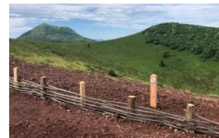
Aménagement de soutènements au puy de Pariou © EMG SMPNRVA
