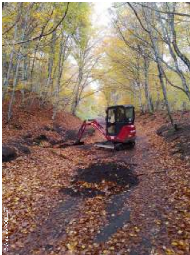
Travaux de curage des renvois d'eau sur le chemin des Gravouses
