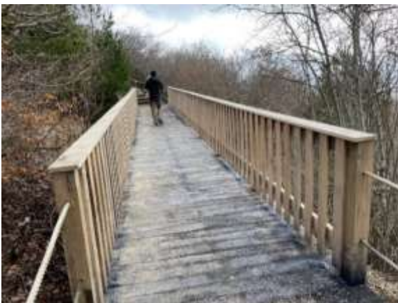
←← Chantier Passerelle Pariou terminé
