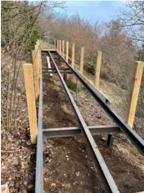
←← Chantier Passerelle Pariou – Assise métallique
