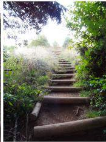
Automne 2016 : Haut du chemin nord : ravines fixées et végétalisation à travers les branchages
