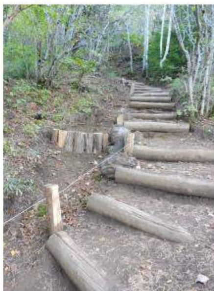
2016 : déplacement des marches contre le talus + fil guide + seuil dans la zone ravinée + calage en grosse pierres
