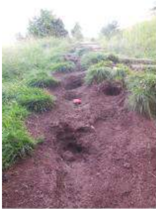
2015 : Haut du chemin nord : élargissement et ravinement des 2 côtés des marches.
