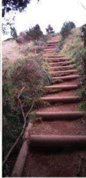
Automne 2015 : Haut du chemin nord : remplissage des ravines avec des branchages + coupes d'eau
