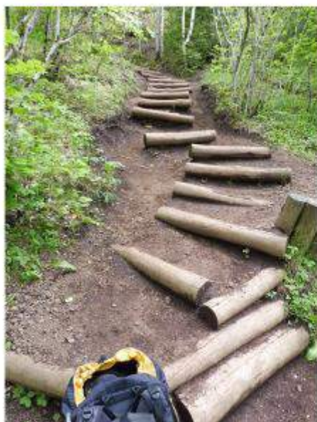
Chemin sud est en 2015 : surcreusement + contournement des marches / élargissement du chemin
